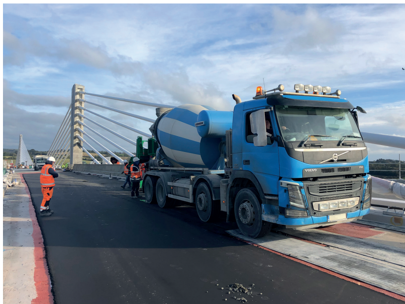
Das Ortbetonschutzwandsystem LT 104 wurde auf der Barrow River Bridge – N25 Bypass, New Ross installiert
