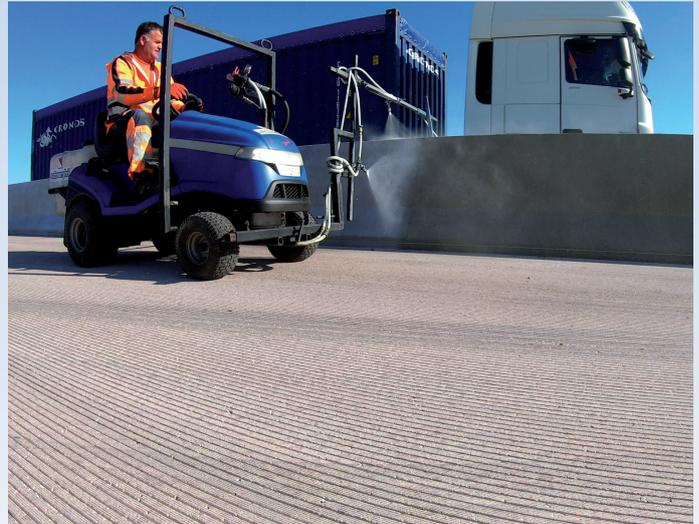
Bild 4: Rechtzeitiges und automatisiertes Nachbehandeln sichert die Qualität der fertigen BSWO
