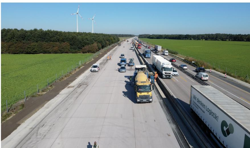
Bild 2: Der Ortbeton hat kurze und schnelle Lieferwege, die Tagesleistung der BSWO-Herstellung liegt bei 500 m und höher
