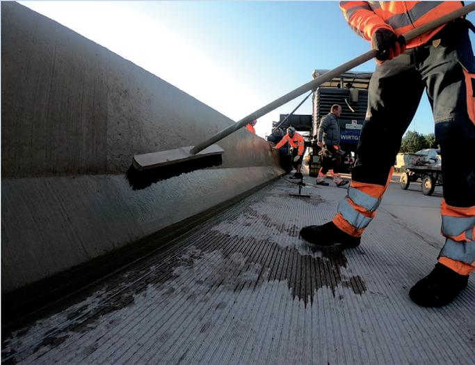
Bild 3: Die Nachbearbeitung an der BSWO endet mit dem obligatorischen Besenstrich
