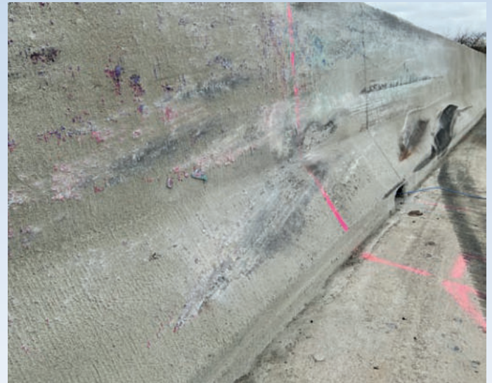
Bild 4: Ortbeton macht Reparaturen zur Mangelware, Farbstreifen und kleine Schrammen sind symptomatisch für einen Fahrzeuganprall. Das Foto zeigt die kürzlich geprüfte LT 205-SF nach dem TB51 Busanprall: Keine Verschiebung, keine Beschädigung, keine Reparatur
