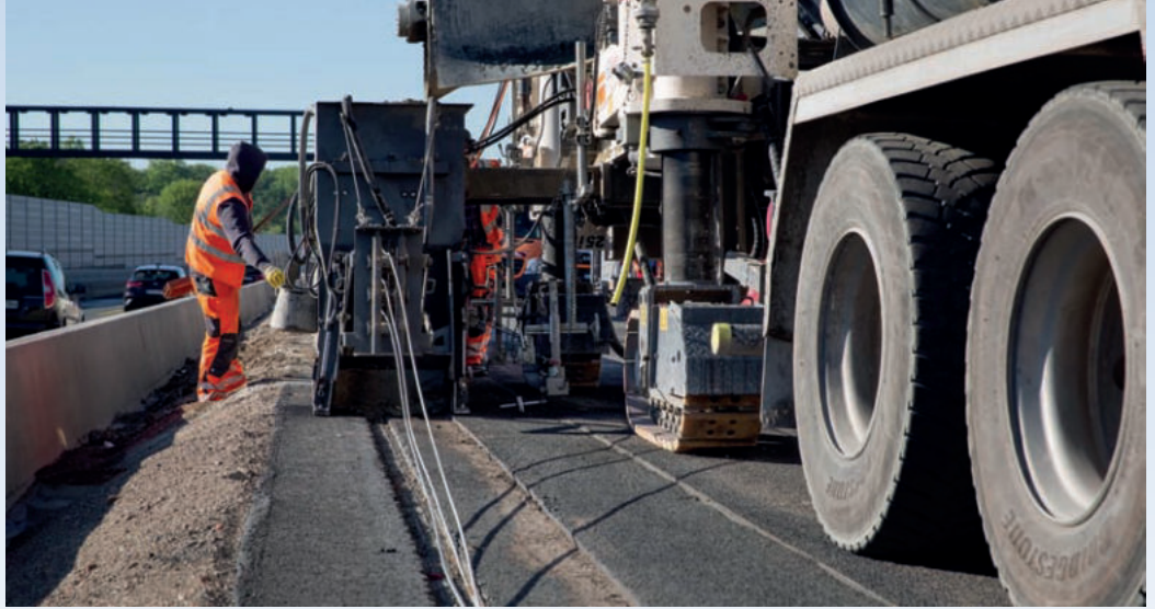
Bild 2: Der Ort beton garantiert bauartbedingt einen hundertprozentigen Verbund des Fahrzeug-Rückhaltesystems mit der Unterlage
