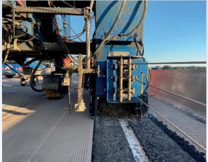
Bild 1: Eine Schutzeinrichtung wird auf einem eigenständigen kompakten Fundament aus Asphalt direkt an der Fahrbahnkante einer Betonfahrbahn hergestellt (Foto: Wallstop)
