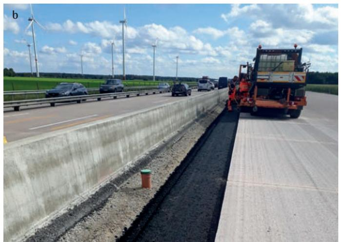
Bild 2: Herstellung des Unterbaus für das Streifenfundament (2a). Der Einbau des Asphalt-Streifenfundaments erfolgt i. d. R. mittels speziellem Asphaltfertiger bzw. Gleitschalungsfertiger in Ortbeton-Bauweise (2b) (Fotos: Wallstop)
