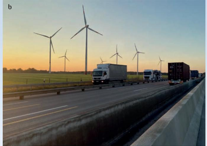
Bild 3: Neu hergestellte dreispurige Betonfahrbahn, der zweite Strang der Mittelstreifenschutzeinrichtung wird als BSWO auf einem kompakten Streifenfundament direkt an der Fahrbahnkante installiert (3a). Mittelstreifen der A 7 mit beiden fertiggestellten BSWO (3b) (Fotos: Wallstop)
