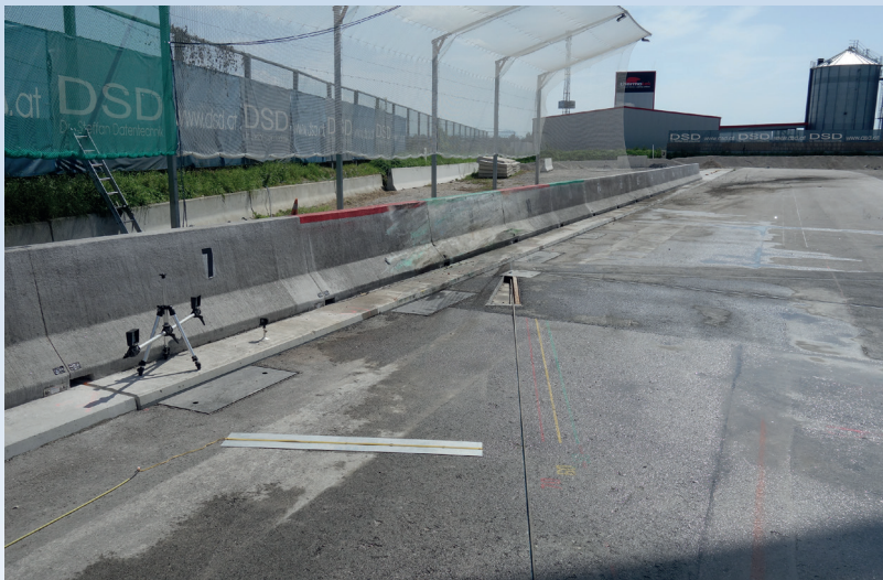
Bild 4: Frei aufgestellte Betonschutzwand nach den drei durchgeführten Anprallprüfungen TB11, TB32 und TB51. Keine Verschiebung und keine Beschädigung bedeuten, keine Reparatur erforderlich
