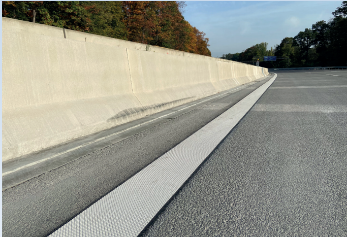
Bild 3: Die Farbstreifen auf der Betonschutzwand resultieren von einem Anprallereignis. Sehr oft findet nur ein Reifenkontakt statt und die Fahrzeuge bleiben nach dem Kontakt fahrbereit. Bei Pkw-Anprallen ist bei Betonschutzwänden im Regelfall keine Reparatur erforderlich
