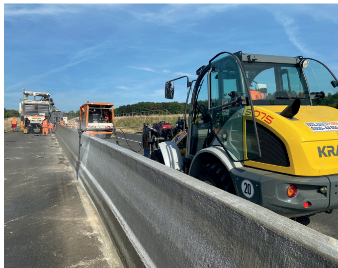
Bild 4: Rechtzeitiges Nachbehandeln schützt den frischen Beton vor dem Austrocknen
