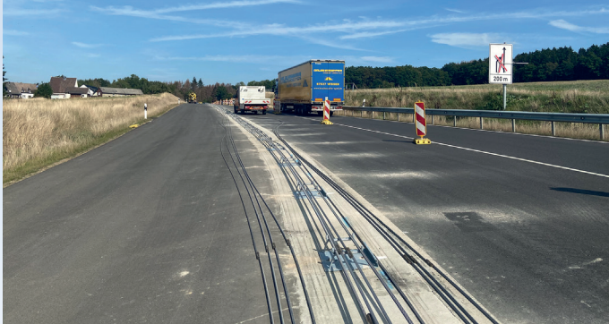
Bild 1: Die Schubplatten werden im Abstand von 3 m vorinstalliert. Auf den Schubplatten werden die beiden unteren Bewehrungseisen befestigt
