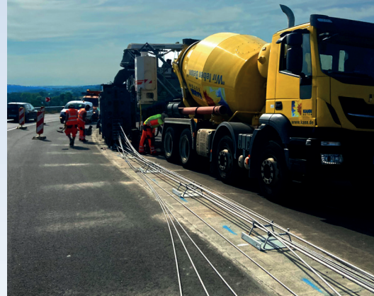
Bild 2: Die restlichen 10 Bewehrungseisen sind gleichmäßig über den Querschnitt verteilt und werden von vorn in die Gleitschalung eingeführt
