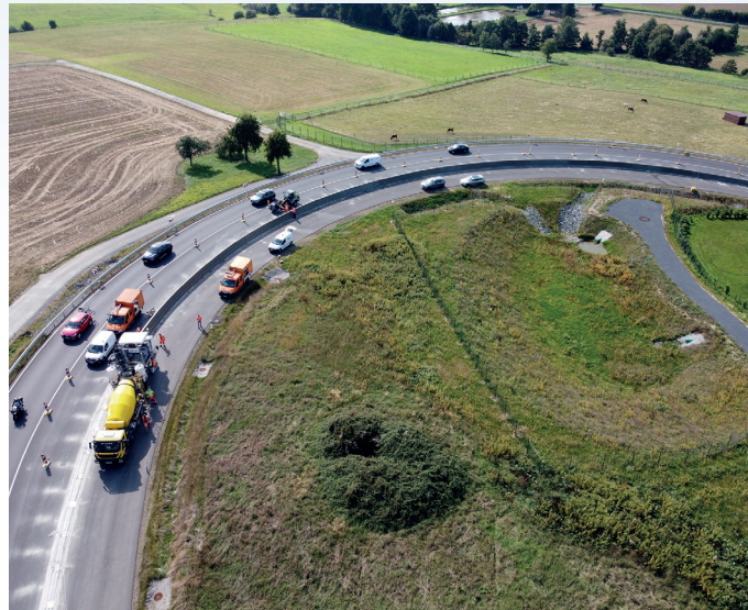
Bild 3: Die Herstellung der Ortbetonschutzwand LT 104 mit den sehr anspruchsvollen Randbedingungen wurde problemlos und im Zeitplan bewältigt
