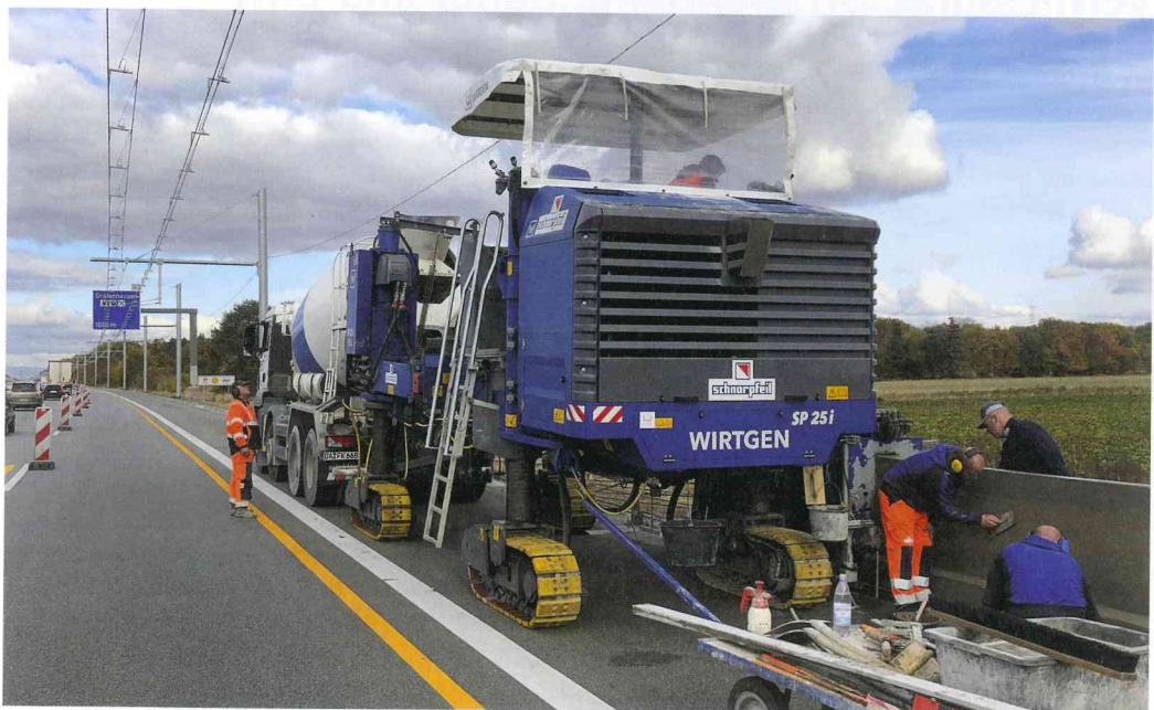
Bild 1: Die Betonschutzwand schützt die Masten, an denen die Oberleitung befestigt ist, vor einem Anprall (Fotos: Schnorpfeil Bau)
