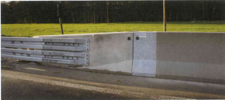
Bild 1: Das bewährte Universal-Anschlusselement LT 1 verbindet die Ortbetonschutzwand mit dem Betonfertigteil LT 8 (Fotos: Linetech)
