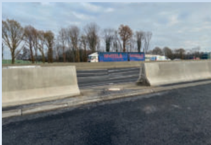
Bild 3a: Eine zweiseitige Ortbetonschutzwand mit einer Unterbrechung für den Einbau eines Wartungssystems LT 1-3-1 an einem Schachtbauwerk
