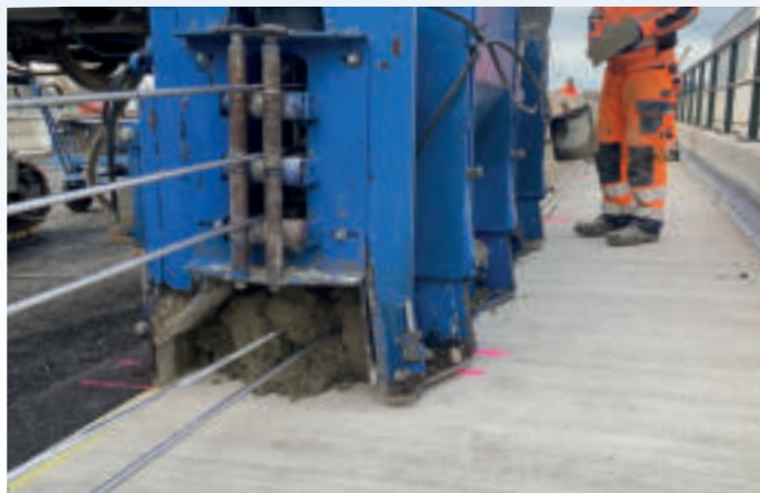
Bild 4a: Eine unverschiebbare Ortbetonschutzwand für Bauwerke LT 201 BW wird im Mittelstreifen der A 3 auf der Brückenkappe installiert. Die Ortbeton-Bauweise garantiert immer einen hundertprozentigen Verbund mit der Unterlage
