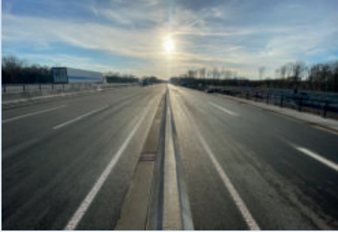
Bild 2a: Die Trennung von Fahrbahn und Abbiegespuren auf der A 3 übernimmt eine zweiseitig wirkende LT 206. Die Schutzeinrichtung ist unverschieblich und bietet somit höchste Sicherheit
