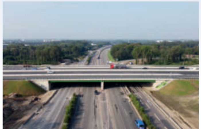
Bild 1b: In einem der letzten Arbeitsschritte wurden im Bereich des AK Hilden alle Fahrzeug-Rückhaltesysteme auf der unter der A 3 verlaufenden A 46 erneuert
