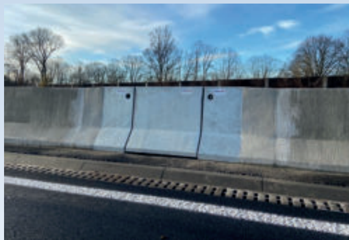
Bild 3b: Das System besteht aus einer verzinkten Stahlhaube LT 3, welche zwischen zwei Universal-Anschlusselementen LT 1 eingehängt wird
