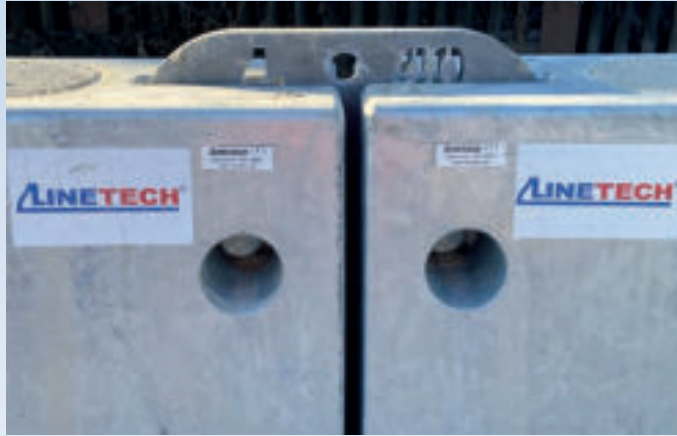
Bild 7b: Die Ortbetonstützwand LT 102 ME wird im Bereich von mehreren kurzen Bauwerken mit dem Kurz-Dilatationssystem LT 1-5-1 ausgestattet. Der Dehnweg beträgt maximal 40 mm, eine Spaltabdeckung ist nicht erforderlich
