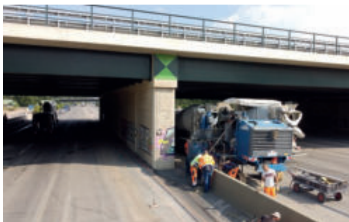
Bild 5a: Im Bereich des Brückenbauwerks teilt sich zweiseitig wirkende Schutzeinrichtung an der A 46 auf in zwei einseitig wirkende unverschiebbare Systeme LT 205-12
