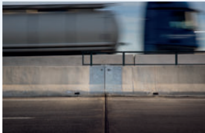
Bild 4b: Im Bereich der Bauwerk Raumfugen werden LT 1-5-1 Dilatationssysteme mit einem Dehnweg von 100 mm installiert. Die LT 5-100 Dilatation ist mit einer LT 905 Spaltabdeckung ausgestattet, um den zulässigen Wert einer vertikalen Fuge von 40 mm einzuhalten
