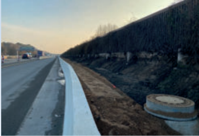
Bild 6a: Südlich des AK Hilden entlang der A 3 wird der Bereich zwischen der Schutzeinrichtung und der Lärmschutzwand hinterfüllt
