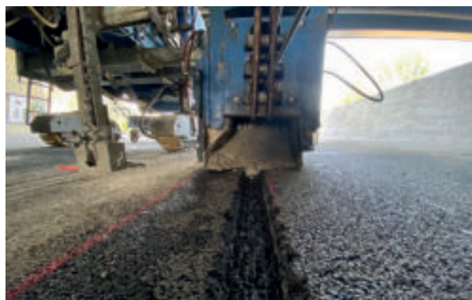
Bild 5b: Fahrbahn und Abbiegespuren werden auf der A 46 im Bereich des Brückenbauwerks durch zwei LT 205-12 sicher voneinander getrennt. Die Einspannung in die gebundene Unterlage erfolgt dabei wie bei der zweiseitig wirkende Schutzeinrichtung mittels Nut in der Unterlage
