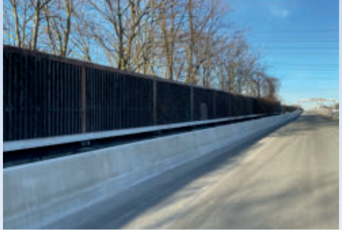
Bild 6b: Die unverschiebbliche Ortbetonschutzwand LT 102 ME bietet die Voraussetzung für Hinterfüllungen mit Erdstoffen, sie baut mit einer Systembreite von nur 54 cm sehr kompakt
