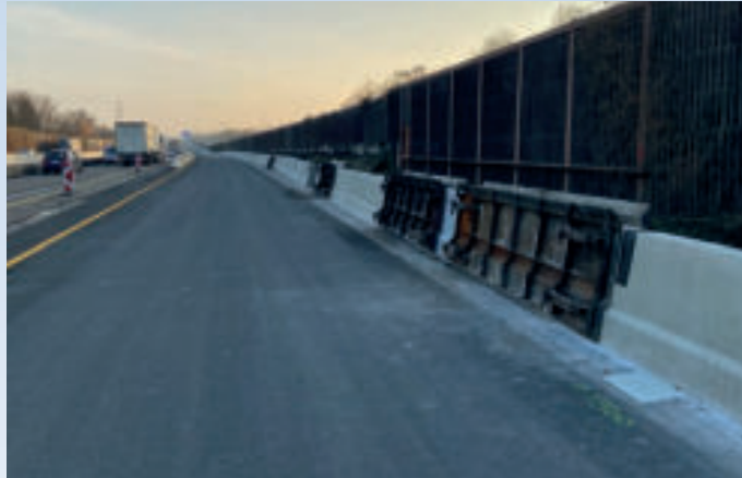
Bild 7a: Die Anbindung von Universal-Anschlusselementen erfolgt mittels Systemschalungen. Vor dem Betonieren werden die Längsbewehrungselemente durch Schweißstöße kraftschlüssig miteinander verbunden
