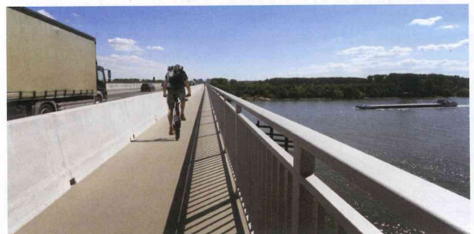
Bild 1: Auf der neuen Schiersteiner Brücke (A 643) über den Rhein schützt die Betonschutzwand LT 104 Radfahrer, Fußgänger und den Schiffsverkehr sicher vor den Kraftfahrzeugen (Fotos: Linetech)
