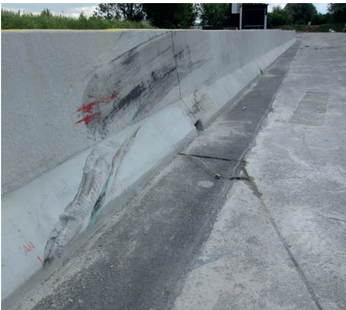
Bild 3: Typisches Erscheinungsbild nach einem Anprall eines PKW oder leichten Nutzfahrzeuges. In der Regel sind keine Reparaturen erforderlich
