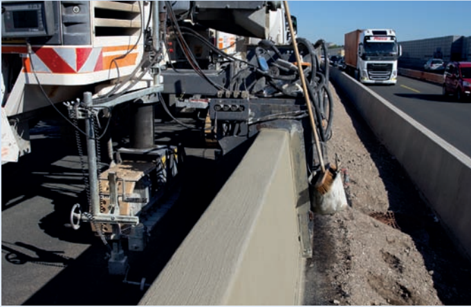
Bild 2: Ortbeton garantiert hohe Einbauleistungen, konstante Leistungseigenschaften bei höchstem Schutzniveau und Flexibilität in allen Örtlichkeiten
