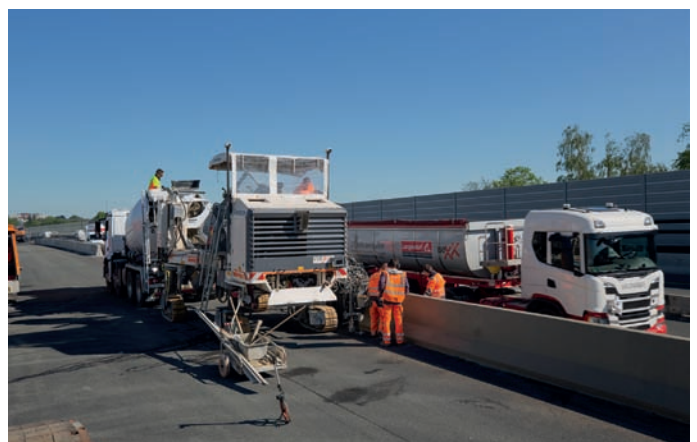
Bild 1: Auf der A 43 im Bereich des AK Recklinghausen wurden im Zuge einer grundhaften Erneuerung des 10 km langen Abschnittes alle Schutzeinrichtungen in Ortbetonbauweise installiert
