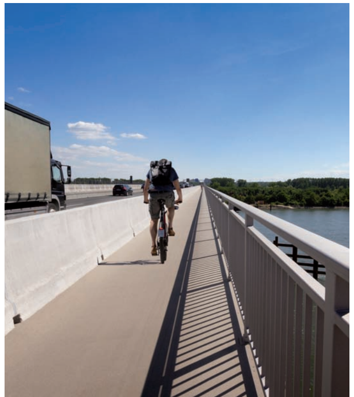
Bild 1: Auf der neuen Schiersteiner Brücke (A 643) über den Rhein schützt die Betonschutzwand LT 104 Radfahrer, Fußgänger und den Schiffsverkehr sicher vor den Kraftfahrzeugen (Fotos: Linetech)
